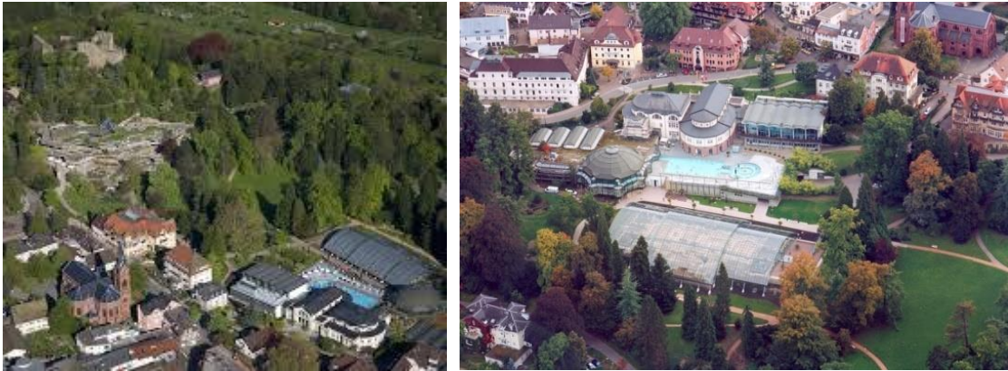
Abbildung 5,6: Gesamtansicht von Südosten, Gesamtansicht von Norden (v. links)
